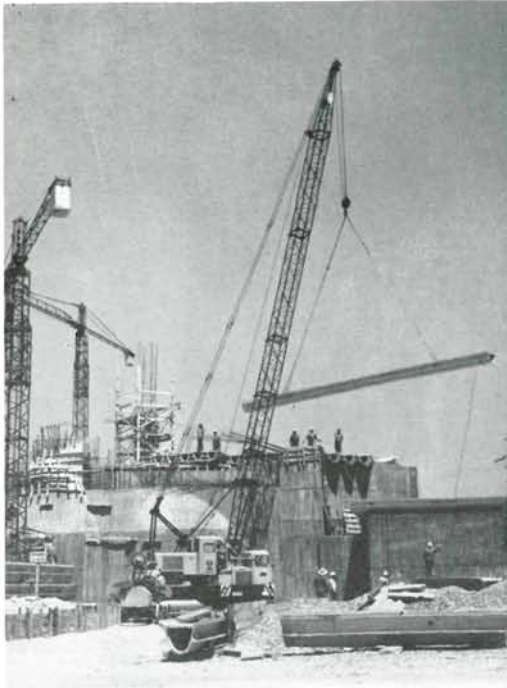
Encofrados de los lóbulos del ábside.
