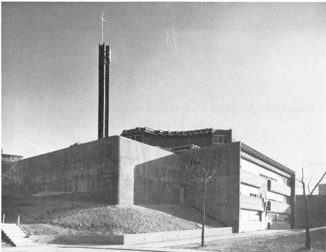
Fachada norte y viviendas de sacerdotes.
