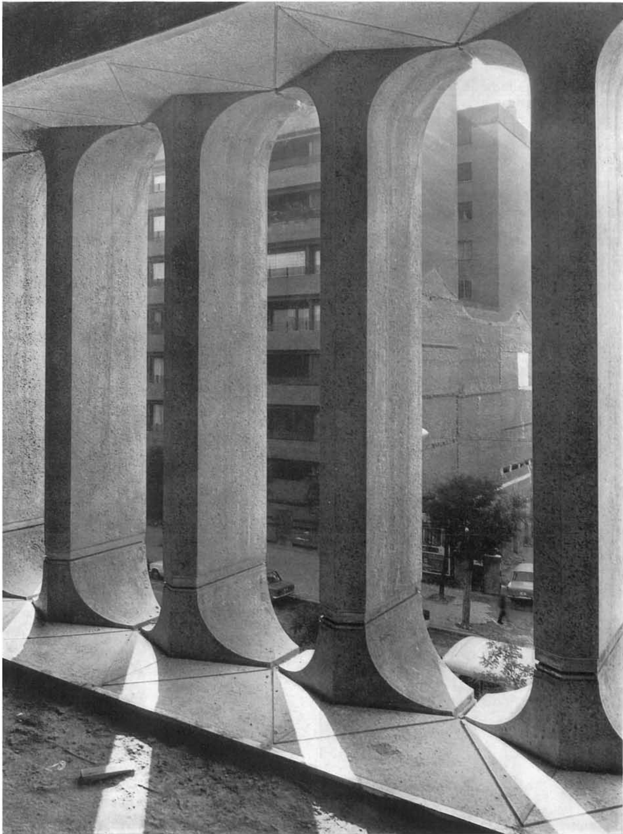
Vista interior de piezas de fachada y pasillo perimetral terminado.
