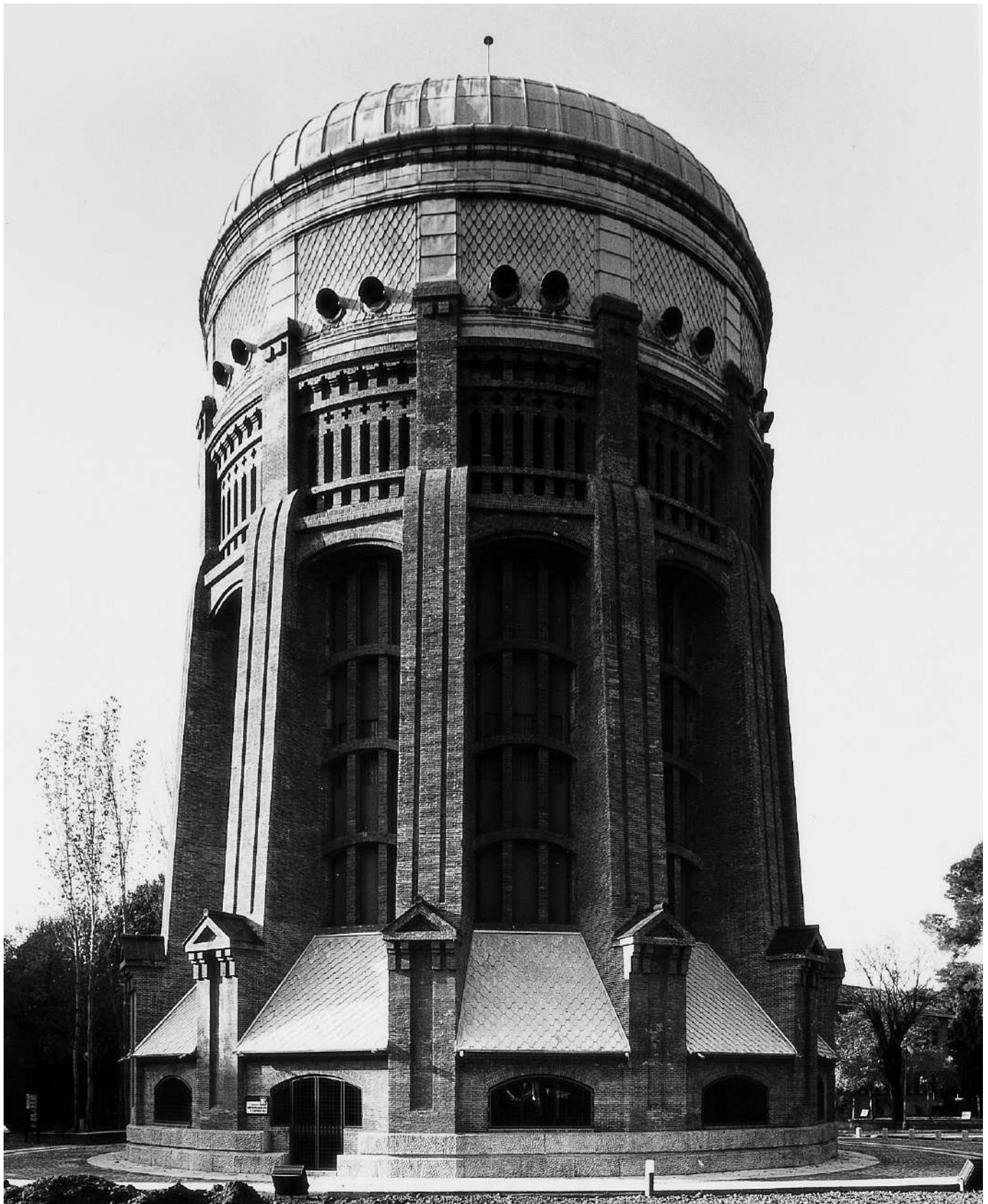
Deposito elevado Canal Isabel II.
