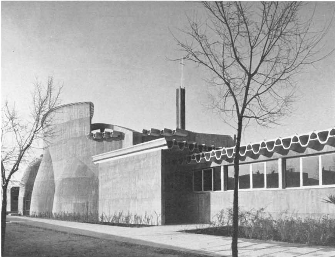
Fachada posterior y ábside.
